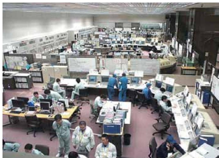
▲圖4 用過核燃料再處理廠內的中央控制室（來源：Plutonium, Spring 2012 No.77, pp.11-17）
