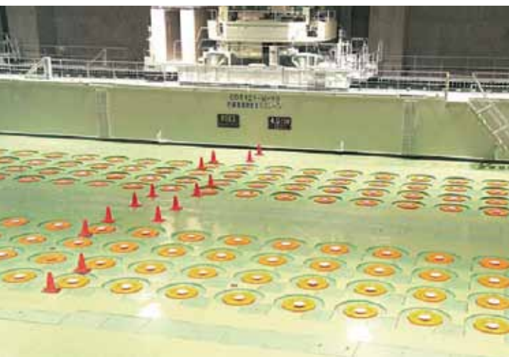
▲圖3 玻璃固化之後的高放射性廢棄物貯存容器存放在地板之下（來源：Plutonium, Spring 2012 No.77, pp.11-17）
